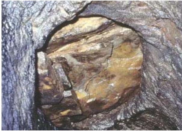
Photo 11 : Dalle d'obturation du regard de la galerie 7B (J. Provost).
