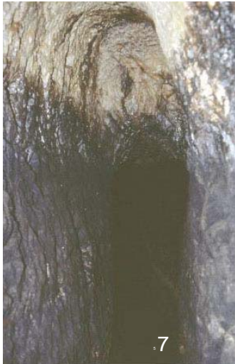
Photo 7 : Au plafond : décalage altimétrique à la jonction des galeries 6B et 7A (H. Paitier)..
