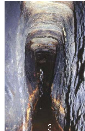
Photo 2 : Bande d'oxydation en paroi de la galerie, témoin de la section mouillée du tunnel (J. Provost).
