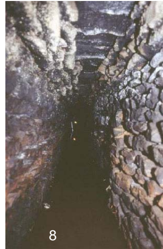
Photo 7 : Au plafond : décalage altimétrique à la jonction des galeries 6B et 7A (H. Paitier)..
